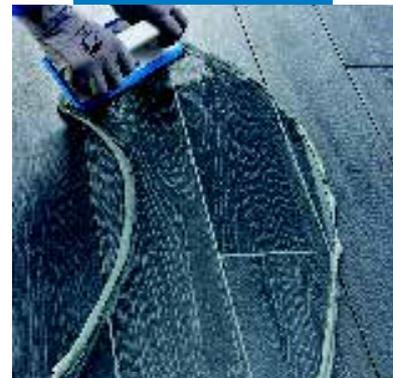
Заполнение с **Kerapoxy Design** пола из фарфоровой плитки под дерево с помощью резинового шпателя
